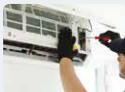
Reparación de aire acondicionado
