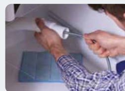
Inspección de alcantarilla/drenaje
